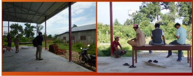
村人で工場を建設
